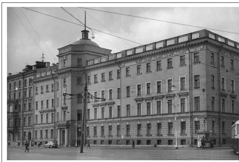
Императорский Археологический институт в Санкт-Петербурге, основан в 1877 г. (Здание, в котором находился Институт, современное фото)
